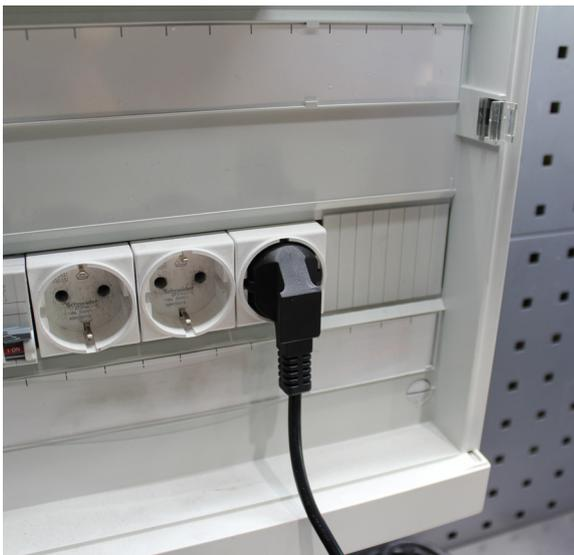
5. Conectamos el enchufe tipo F o Schuko a la toma de corriente de la pared.
